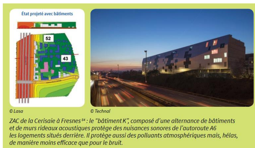
Figure n°6. Cas de la Zac de la Cerisaie. Source : ADEME, convergence des actions bruit-climat-air
